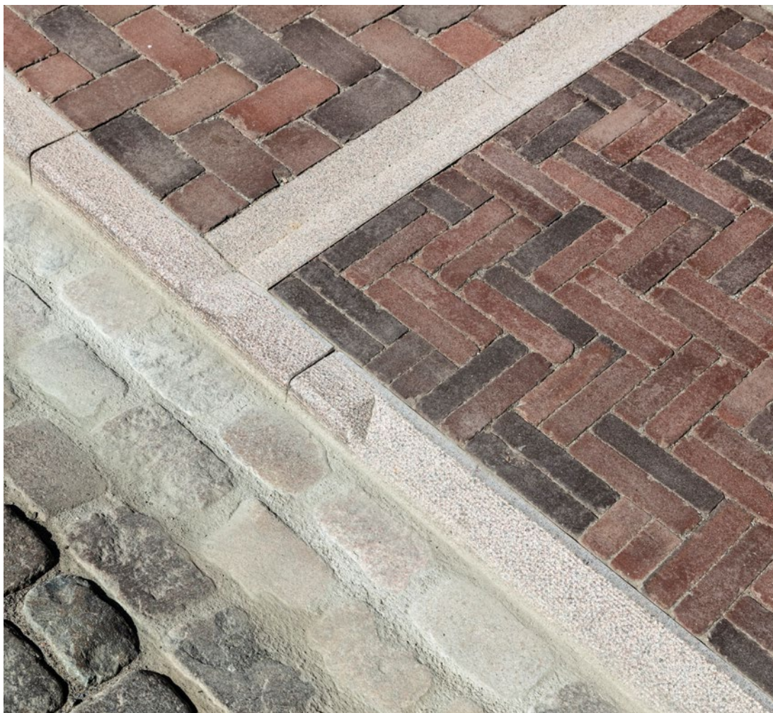
Die Pflasterklinker in Højer haben einen dunklen Rotton, der ideal zur Stadt passt, und wurden in zwei verschiedenen Formaten speziell für Højer hergestellt.
