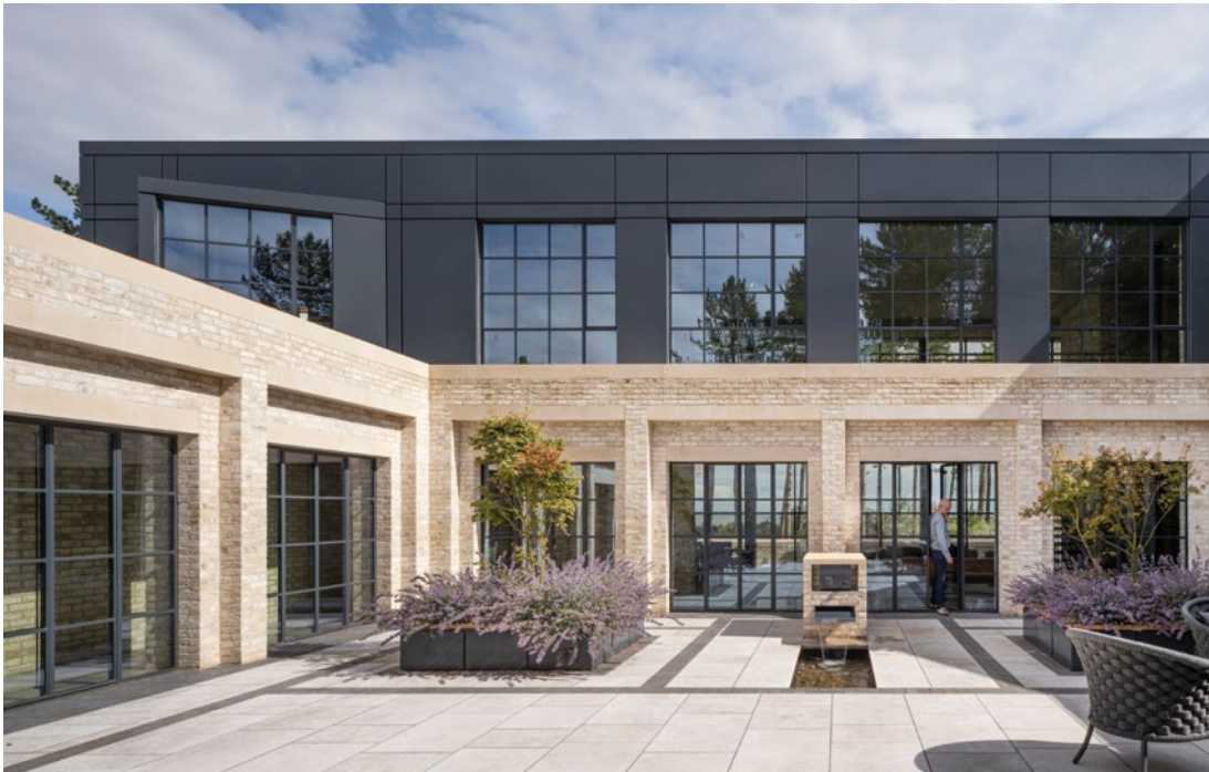
Das hellbeige Ziegelmauerwerk der Fassade bildet einen schönen Kontrast zur Metallverkleidung des ersten Stocks.
