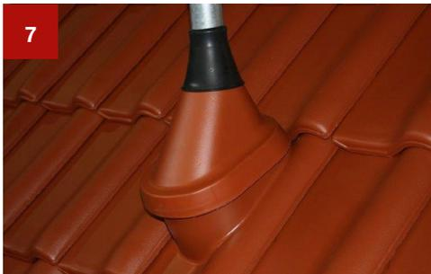
Den Durchgangsziegel und die Antennenhaube über den Mast schieben. Die Abdichtung erfolgt mit der Abdeckkappe (Gummimanschette).
