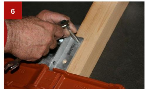
Das Grundgestell mit den beiliegenden Holzschrauben befestigen.
