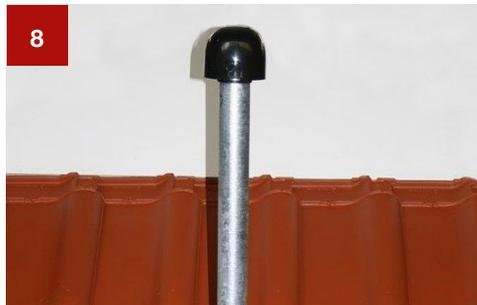
Mastabdeckkappe mit Kabelführung auf den Antennenmast montieren.
