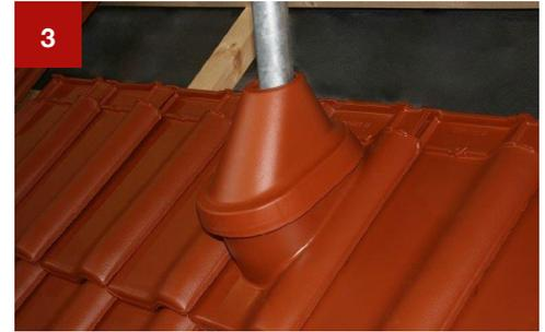
Den Mast genau auf dem Durchgangsziegel und der Antennenhaube ausrichten.
