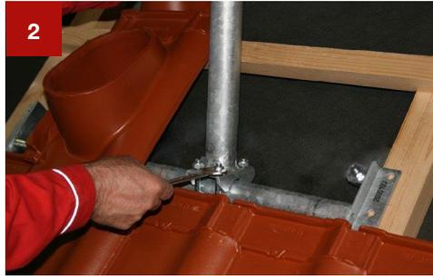
Den Mast am Grundgestell mit den Schrauben fixieren aber nur soweit anziehen, dass noch ein Verschieben möglich ist
