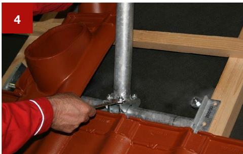
Den Mast mit den Schrauben am Grundgestell befestigen.
