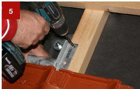
Um ein Aufspalten des Sparrens oder der Konterlatte zu vermeiden, ist ein Vorbohren des Holzes erforderlich.
